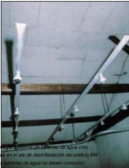
*Figura 20. Sistema de tuberías de agua con rociadores en el ala de desinfección del edificio BW 5b. Estas tuberías de agua no tienen conexión; terminan en las salidas de ventilación. Vea la figura 19.*
